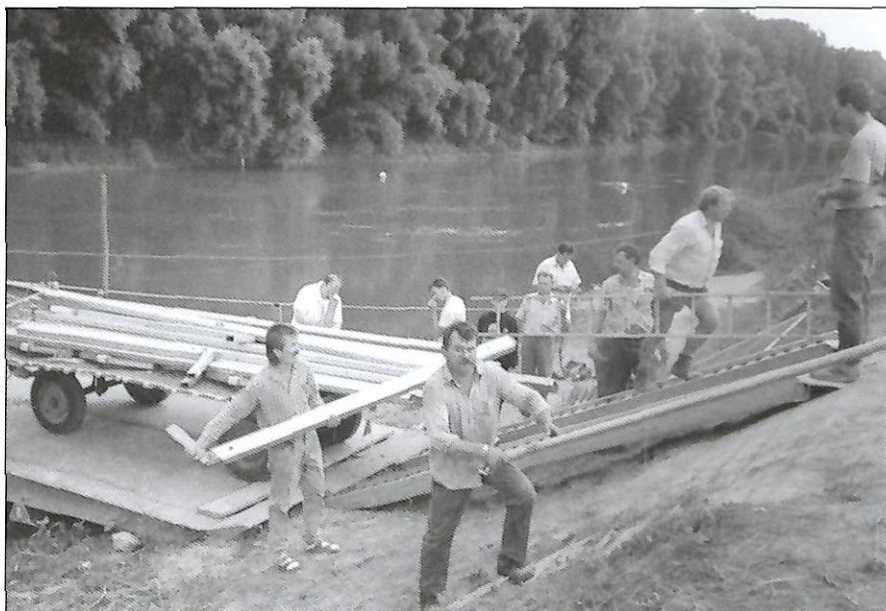
Auch beim Abbau wird jeder Mann benötigt
