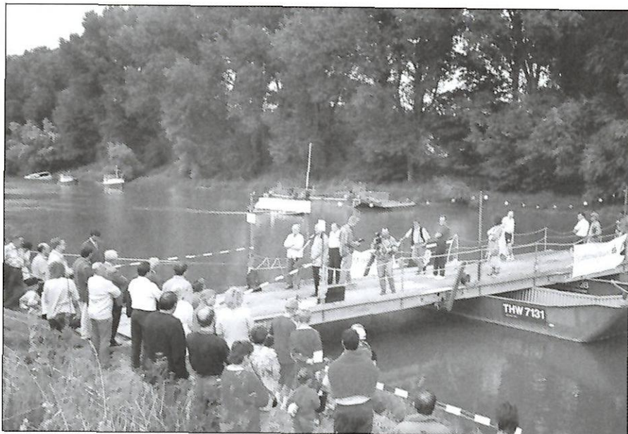
Eine Besonderheit in der Überbrückung des Rheinarmes: die Pontonbrücke
